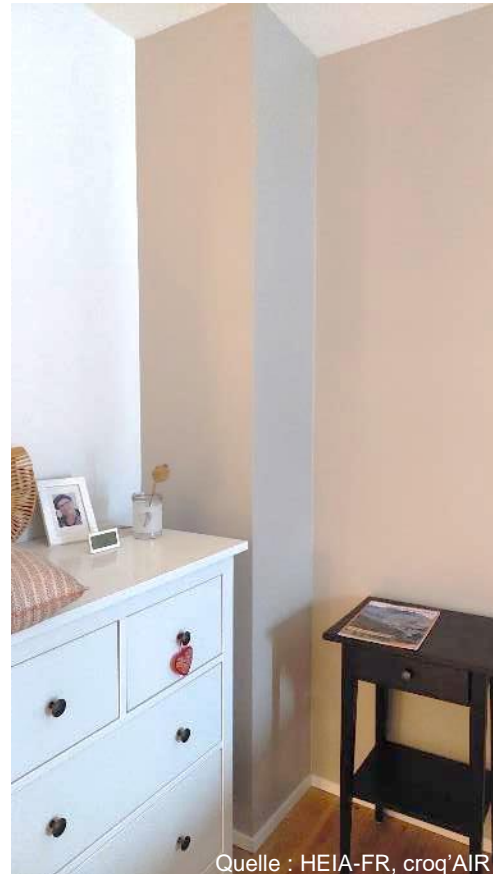
Radonabsaugung in einem Technikschacht
