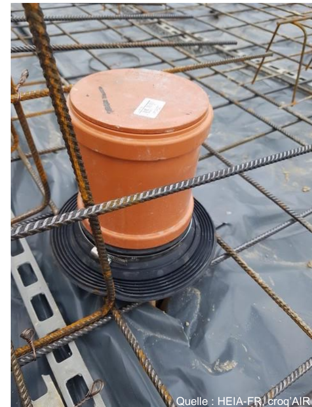
Dichtkragen mit Rohrschelle für die Durchdringung der Bodenplatte
