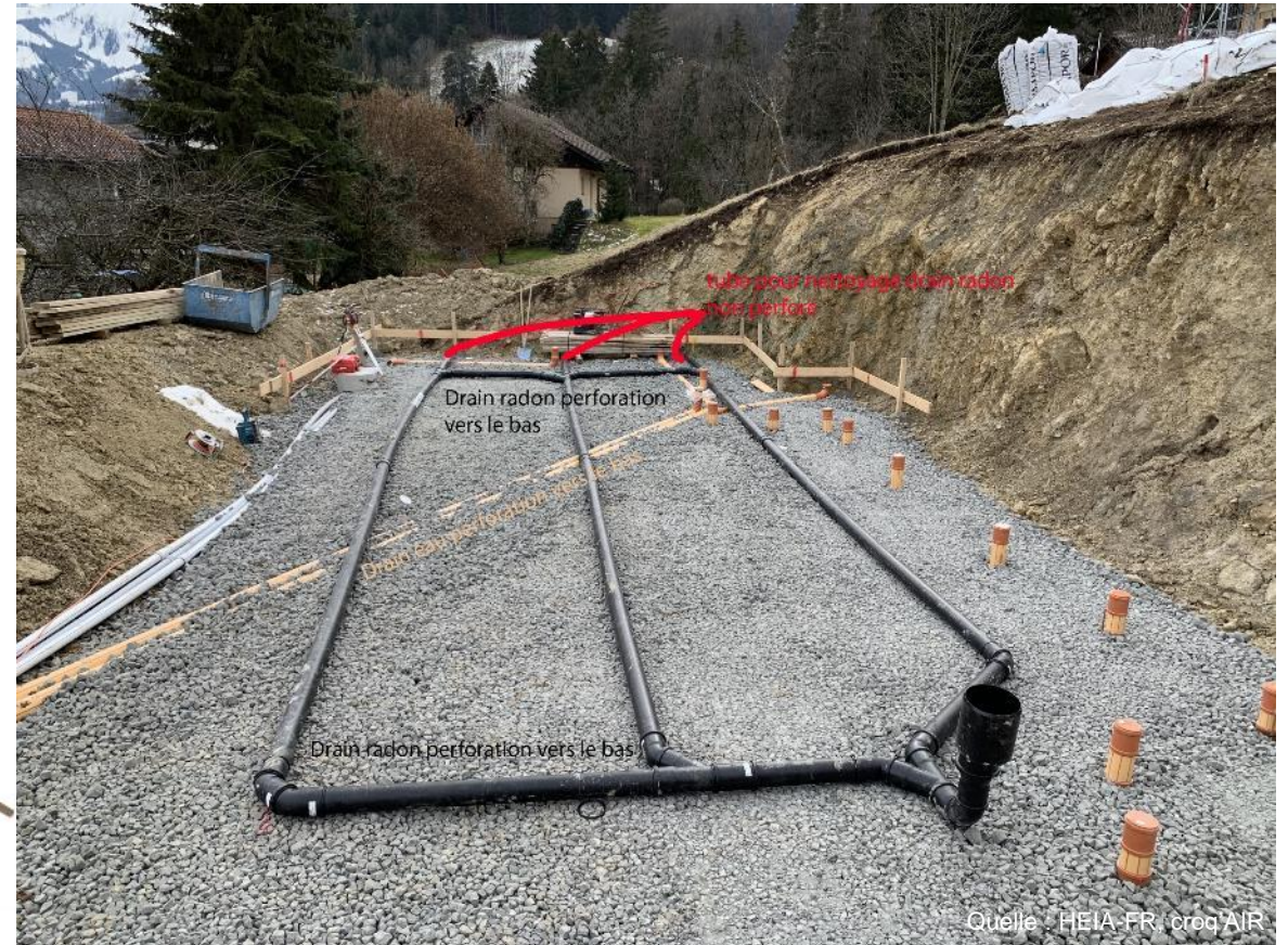
Foto der Radondrainage
