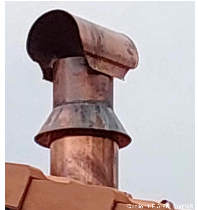
Radonabsaugung auf dem Dach
