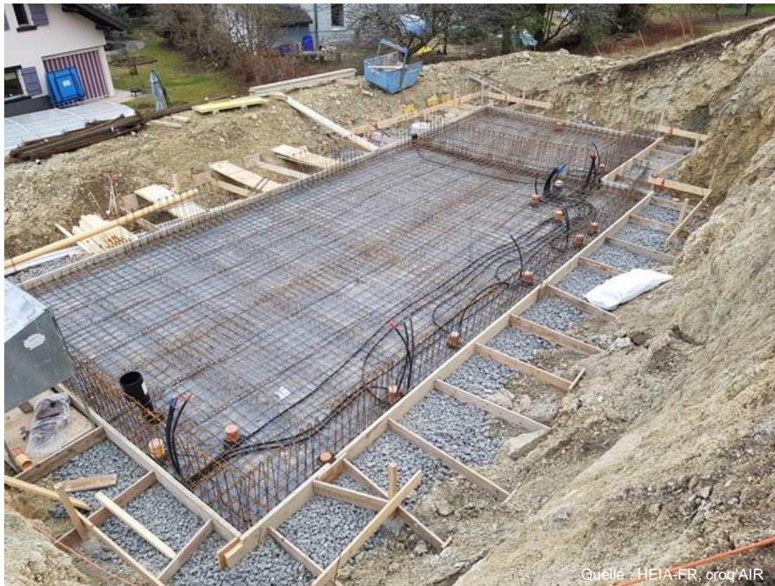
Wasserdichtes Betonfundament
