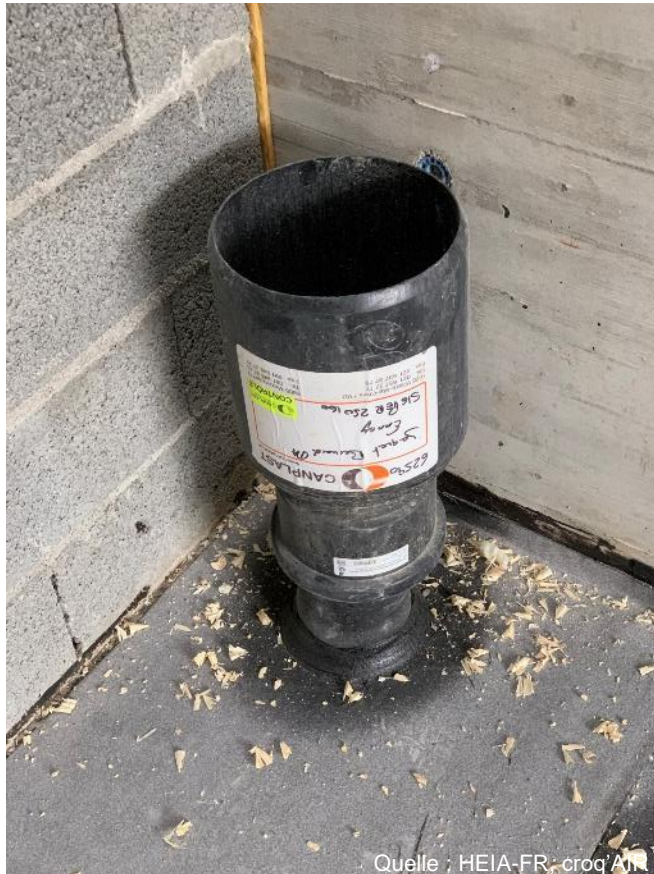
Radonabsaugung : PEHD Ø 200 mm
