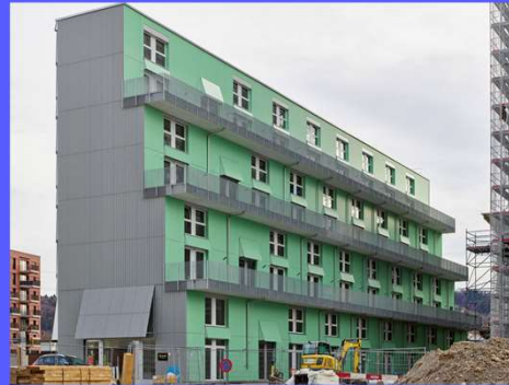
Reduce to the max! -> Längsbau H1, Regensdorf
